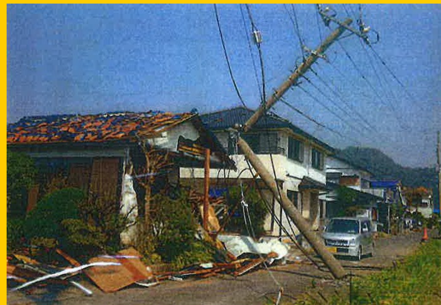
下佐久間 白銀地区 電柱倒壊
