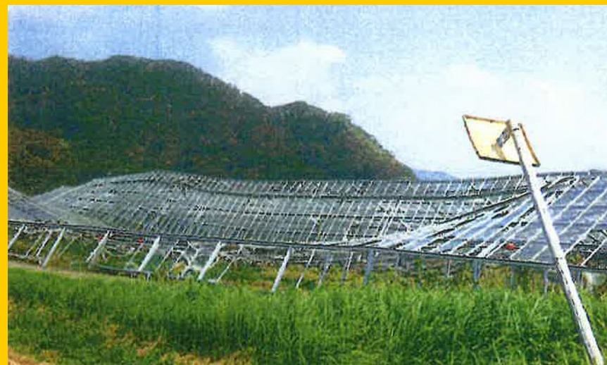
下佐久間 本郷地区 ビニールハウス倒壊
