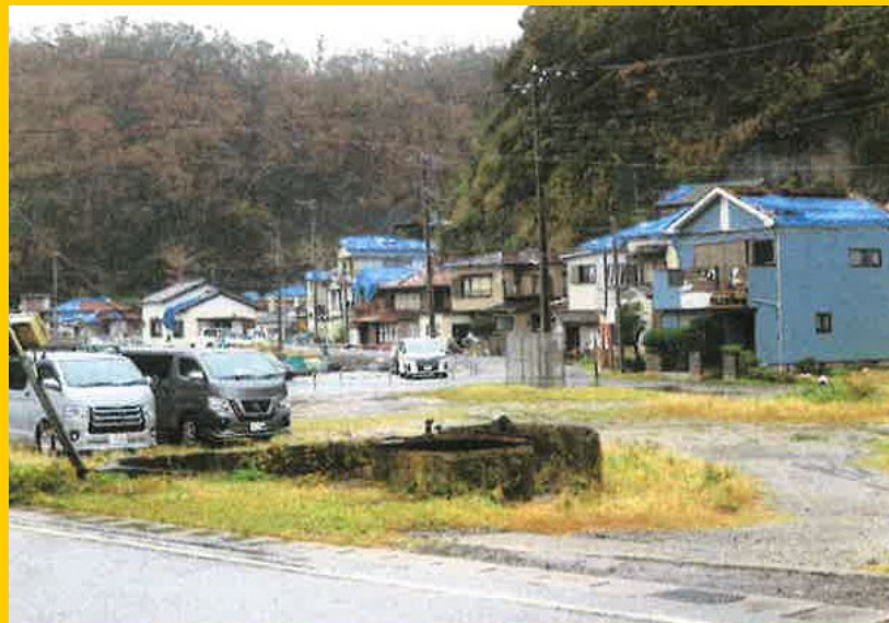
漁港近く民家の屋根が吹き飛んでいる
