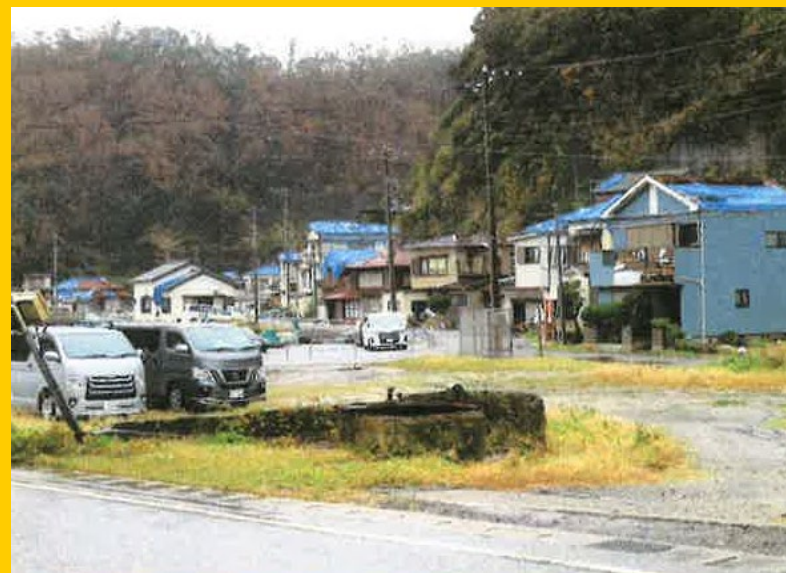
漁港からの道路沿い民家にの屋根瓦破損被害が多く見られた
